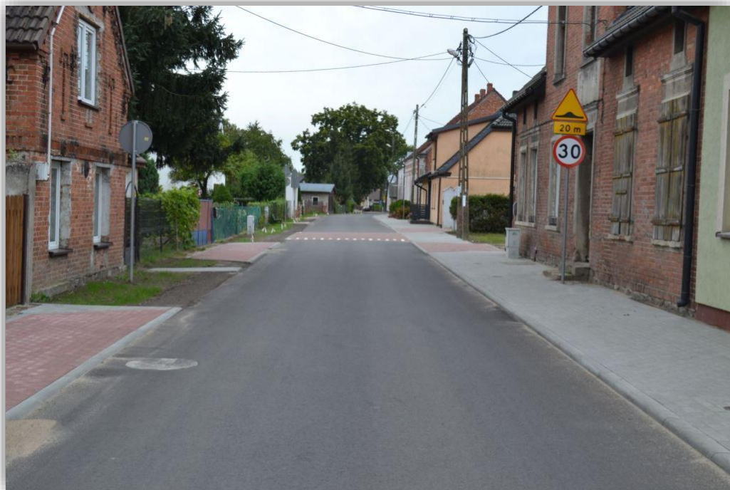
Przebudowa ulicy Miedwiańskiej w miejscowości Żelewo, etap 2
