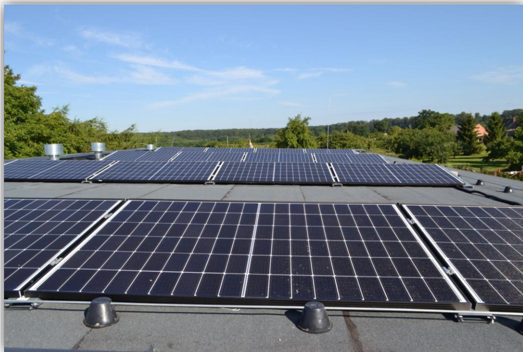
Montaż odnawialnych źródeł energii na świetlicy w Dobropolu Gryfińskim
