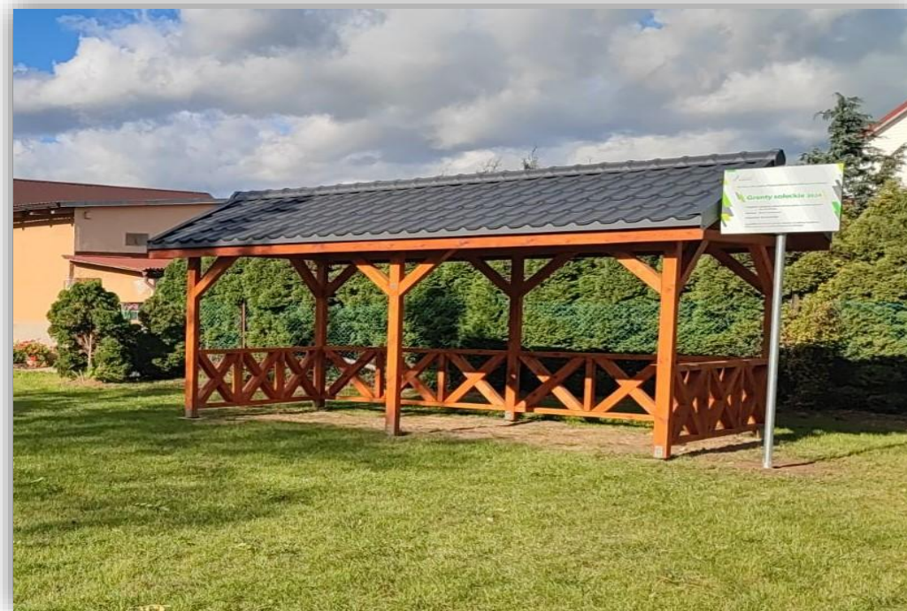
Budowa wiaty rekreacyjnej w Komorówku w ramach dotacji o wartości 15 tys. zł z programu „Granty sołeckie”
