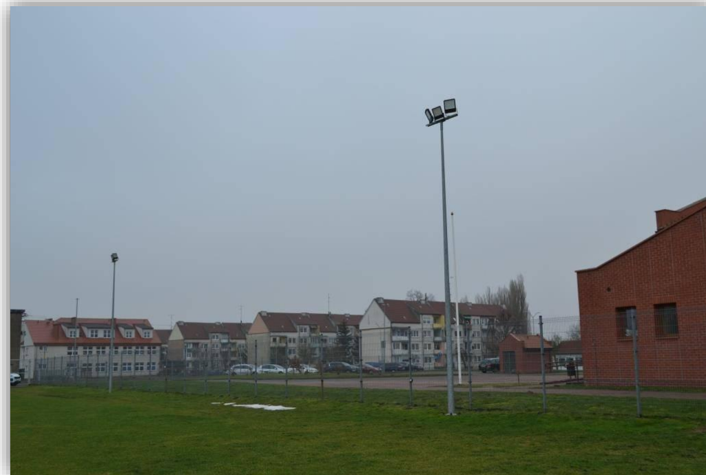
Montaż oświetlenia i zakup wyposażenia na stadion sportowy w Kołbaczu
