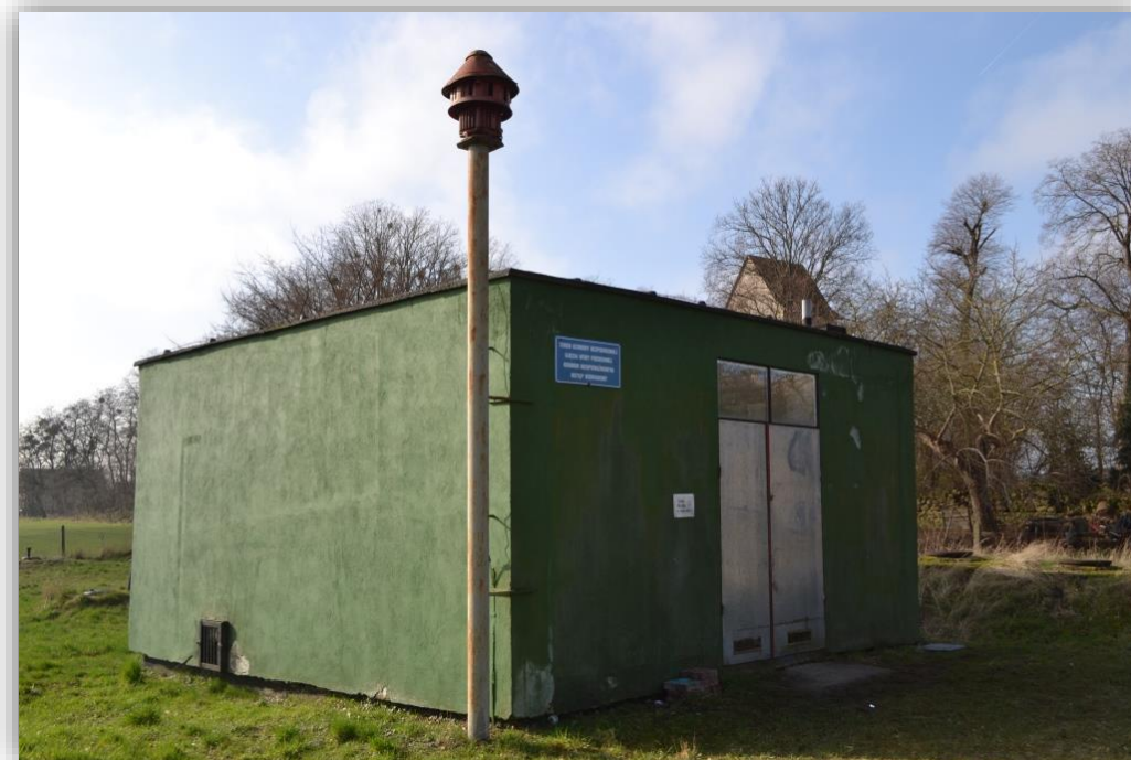
Poprawa gospodarki wodno-ściekowej w miejscowościach Binowo oraz Kołowo
