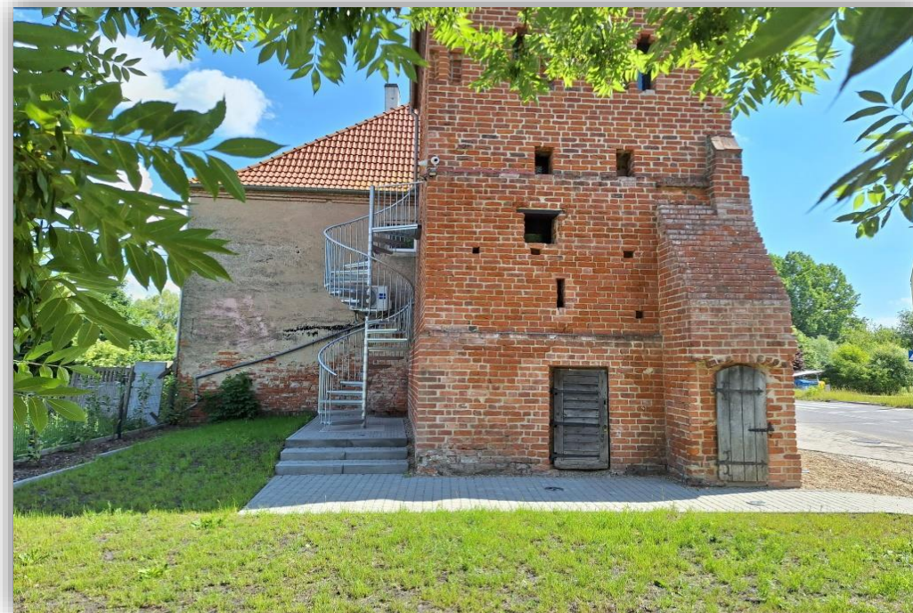
Wykonanie prac konserwatorskich przy baszcie więziennej w Kołbaczu
