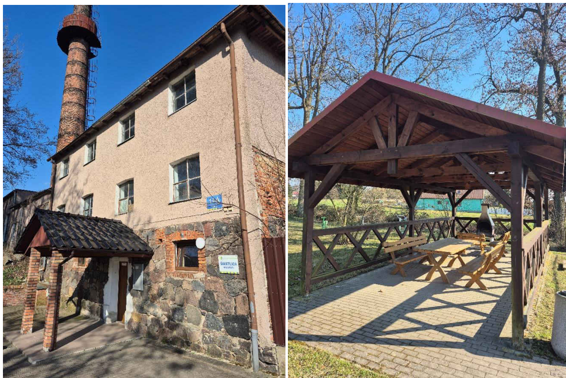
Fot. 12. Świetlica wiejska wraz z otoczeniem w Glinnej
