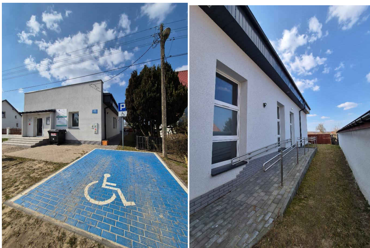
Fot. 14. Dostosowanie świetlicy w Dobropolu Gryfińskim do potrzeb osób z niepełnosprawnościami
