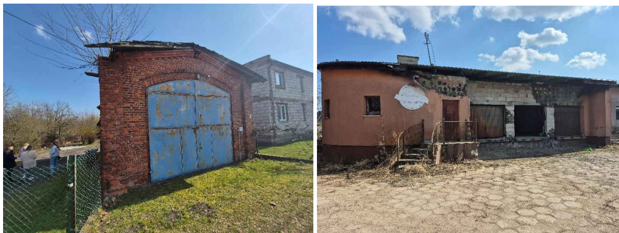
Fot. 5. Zdegradowane obiekty w Starym Czarnowie
